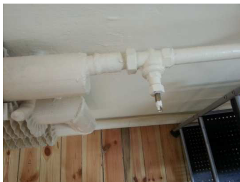
Zdj.: Brak głowicy termostatycznej na grzejniku w pomieszczeniu czytelní
