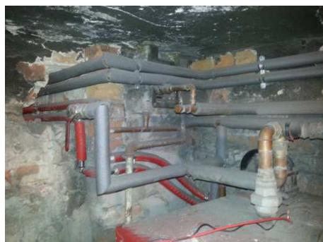
Zdj.: Przewody instalacji C.O. w kotłowni
