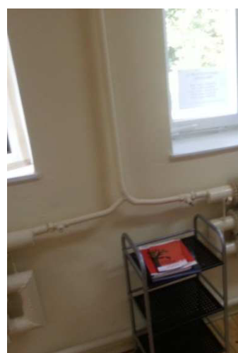
Zdj.: Rozdział górny czynnika grzewczego, instalacja jednorurowa
