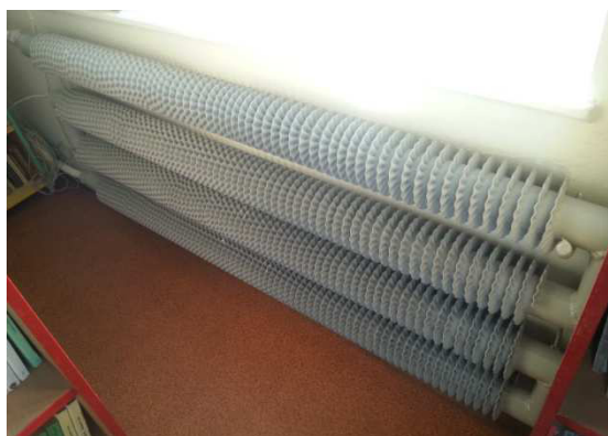
Zdj.: Grzejnik Faviera zlokalizowany w pomieszczeniu biblioteki
